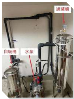
雨水回收系統設備配置圖
