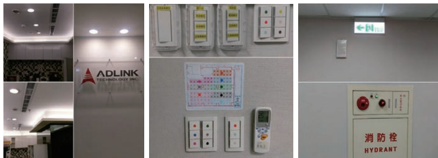
辦公室照明由更換為 LED 及 T5 省電型燈具 消防栓指示燈具更換為省能 LED 燈具 辦公室增設空調及照明總開關及對應控制圖
